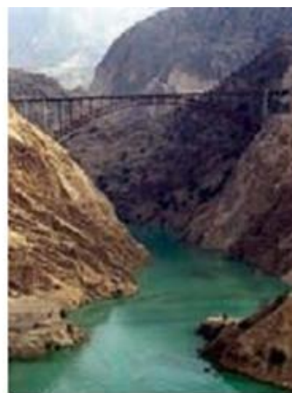
بزرگترین پل قوسی فولادی در ایران پل روی رودخانه کارون
