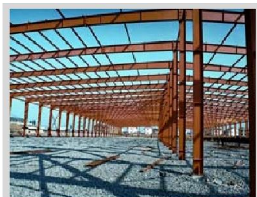
تصویر شماره ۱۴.۱۷. سازه فولادی
