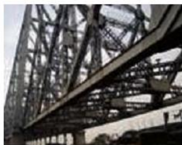
قسمت‌هایی از پل‌های فولادی
