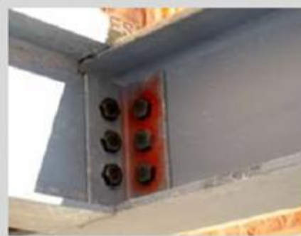
اتصال خشک قطعات فولادی از طریق پیچ و مهره
